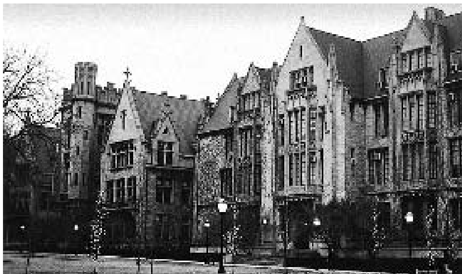
Fotografía 1. Edificio del Departamento de Sociología y Antropología de la Universidad de Chicago. Allí estudió Robert Redfield y era la sede del Local Community Research Program.
